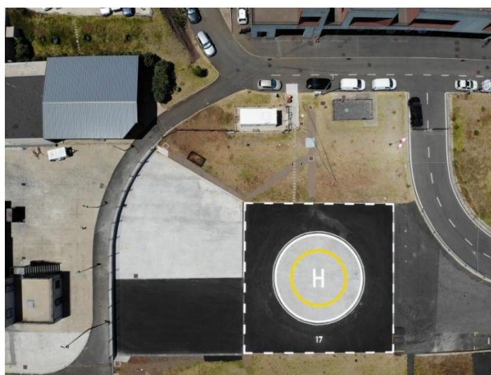
Figura 15 Vista aérea do Heliporto da Cancela ampliado
