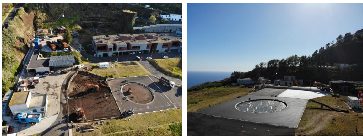
Figura 14 Trabalhos de Ampliação do CMA – Heliporto da Cancela
