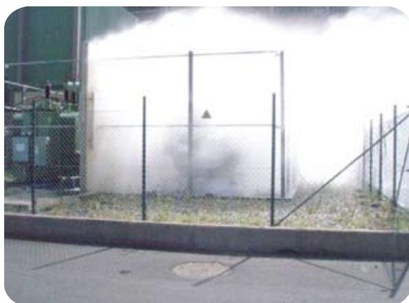
Figura 6 – Sistema de extinção em funcionamento do transformador 30 kV/6kV
